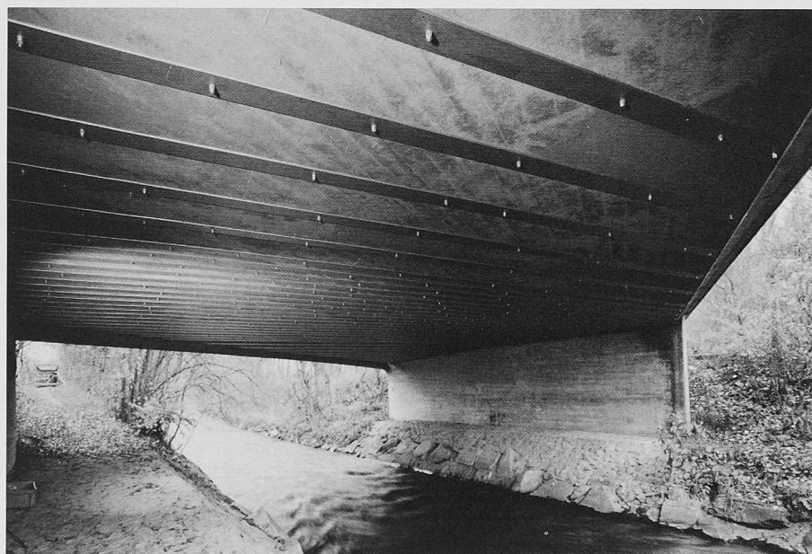
Bild 9. Fertig verstärkte Brücke
