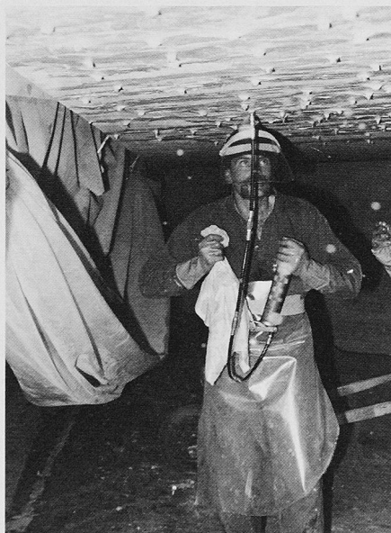
Bild 6. Injektion der Risse in den Nachtstunden
