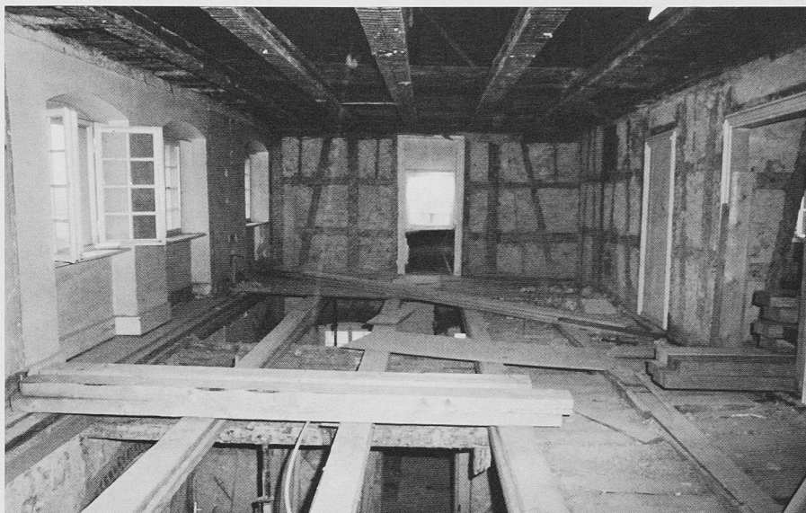
Bild 1. Gasthof Löwen, Vaduz. Obergeschoss während der Bauphase
