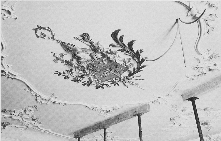
Bild 3. Hotel Hof, Bad Ragaz. Stukkaturdecke
