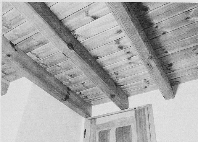
Bild 3. «Aufgehängter» Balken am Türsturz
