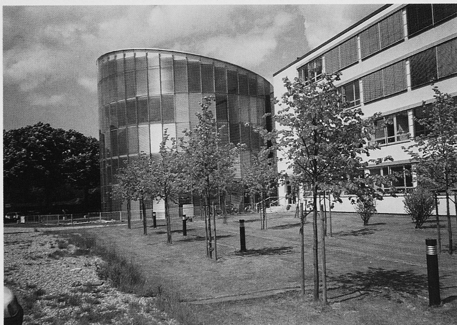
Der Glaszylinder des Technologiezentrums III
