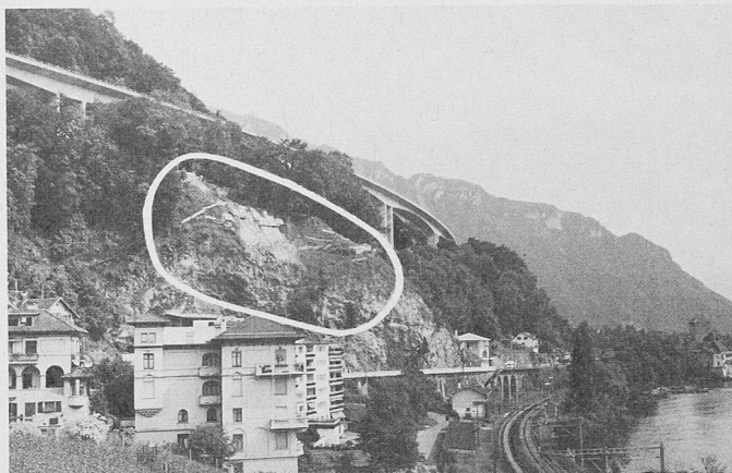
Kurz vor Pfingsten hat sich beim Schloss Chillon ein ca. 100 Kubikmeter grosses Teil des Hanges über dem Felsen gelöst. Das weisse Oval zeigt das mit dem Leica-System APSWin überwachte Gebiet. (Bild: Leica)
