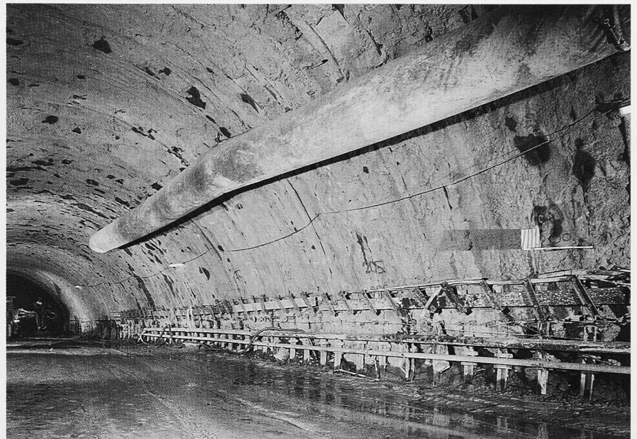
Bild 3. Längsträger mit Injektionsankern, Schlösser der TH-Bögen über der Ausbruchssohle. Blick gegen Vortriebsbrust
