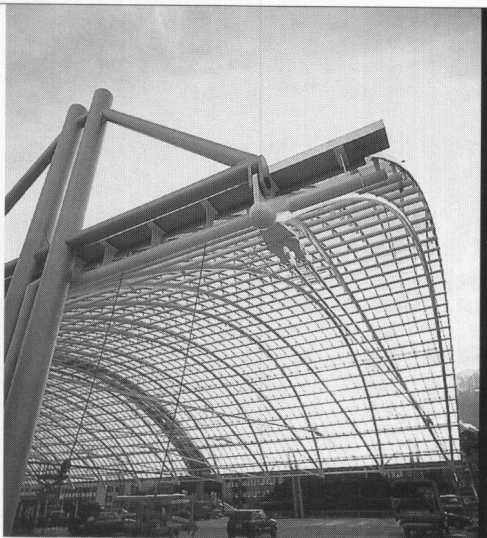
Projekt: Postautostation Chur Hallendach Architekten: Brosi Chur & Obrist St. Moritz
