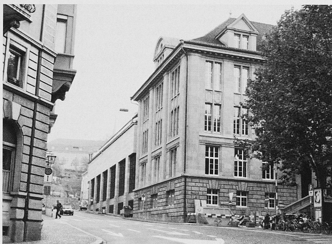
Oben: Blick die Mühlegasse hinauf. Im Vordergrund der ZB-Altbau, daran anschliessend der Publikumstrakt
