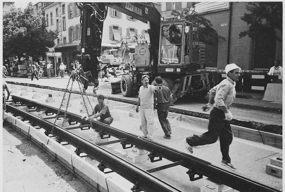
Bild 4. Baustelle Breitenrainplatz/Moserplatz in Bern. Absetzen des Gleises auf die Schienenschemel. Erkennbar sind die auch auf beiden Seiten der zukünftigen Gleistragplatte hochgezogenen Mineralwollplatten
