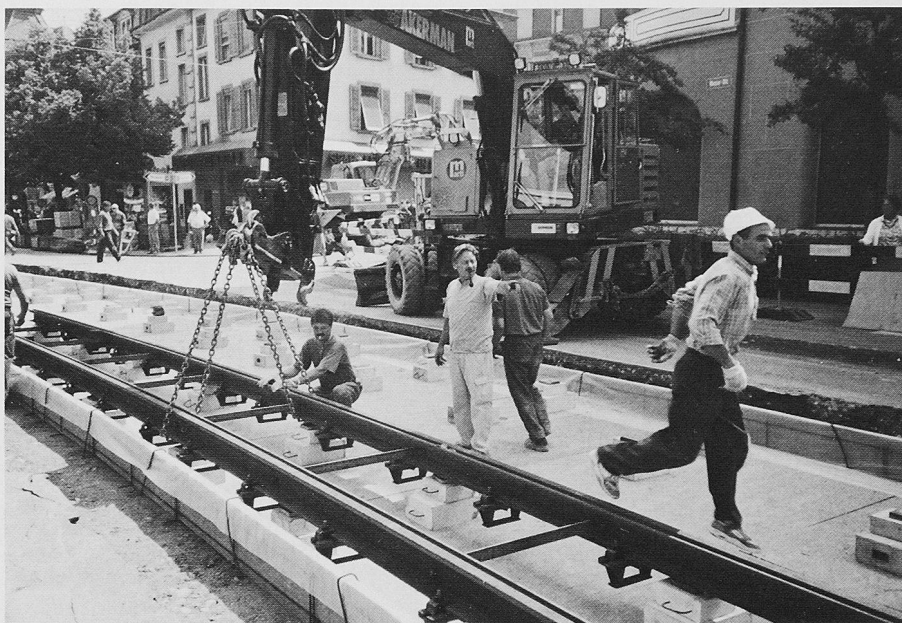
Bild 4. Baustelle Breitenrainplatz/Moserplatz in Bern. Absetzen des Gleises auf die Schienenschemel. Erkennbar sind die auch auf beiden Seiten der zukünftigen Gleistragplatte hochgezogenen Mineralwollplatten
