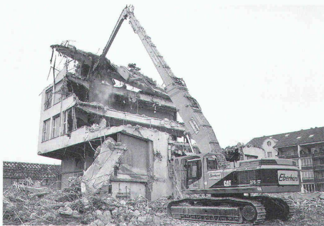
Unser neuestes Kraftpaket: der 85-Tönnner CAT 375. Mit der Langausrüstung erreicht er eine Arbeitshöhe von bis zu 32 Metern(!) und setzt damit neue Massstäbe im rationellen Rückbau.
