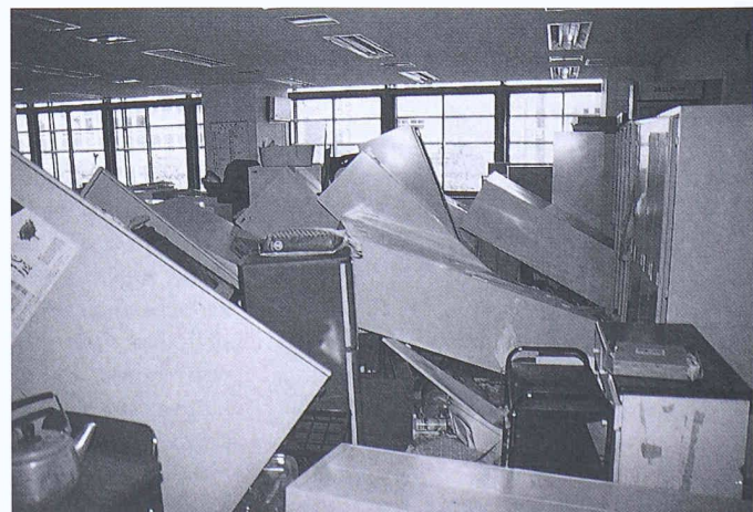
Bild 16. Umgestürzte Büromöbel in Gebäude von Bild 15
