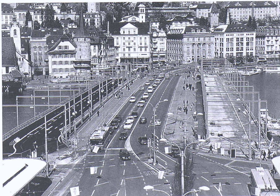
Die alte Luzerner Seebrücke mit den beiden Hilfsbrücken rechts und links, die für rund 18 Monate Bauzeit den Verkehr aufnehmen müssen (Bild: Comet)
