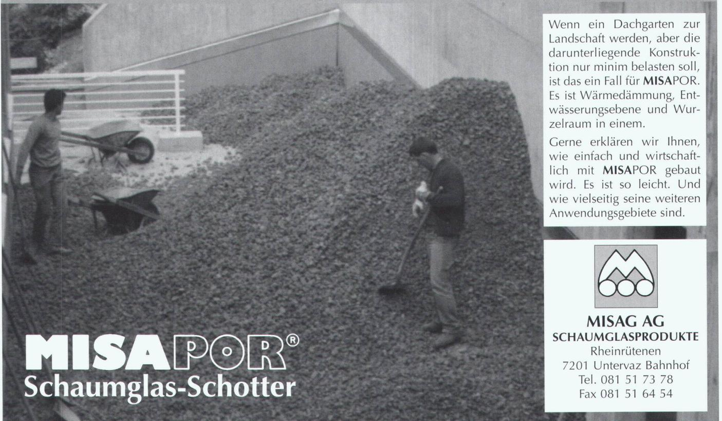
Wenn ein Dachgarten zur Landschaft werden, aber die darunterliegende Konstruktion nur minim belasten soll, ist das ein Fall für **MISAPOR**. Es ist Wärmedämmung, Entwässerungsebene und Wurzelraum in einem.
