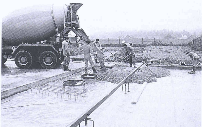
Bild 4. Einbringen des Betons aus dem Fahrmischer
