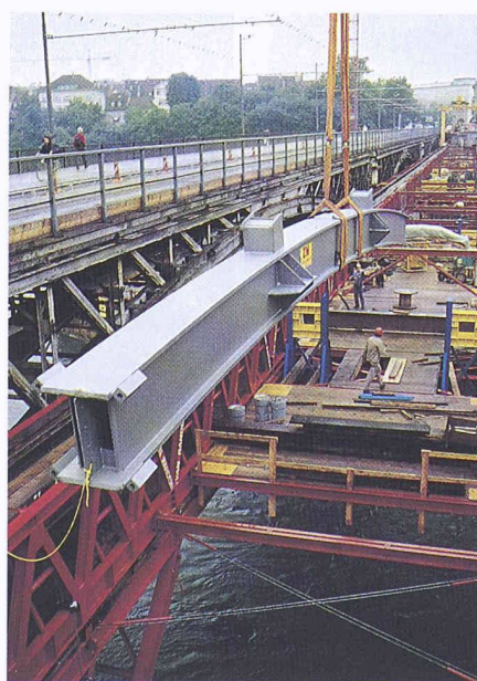
Bild 9. Bogensegment mit einem Gewicht von 32 t während Absenkvorgang auf Montagegerüst zum Umhängen an Portalkrane für den Längstransport (Photo L. Rentsch)
