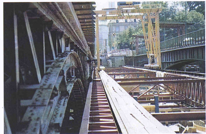
Bild 6. Montagegerüst (rot) mit Portalkran (gelb), rechts verschobene Seitenbrücke, links Stahlkonstruktion der noch unter Verkehr stehenden alten Brücke (Photo L. Rentsch)
