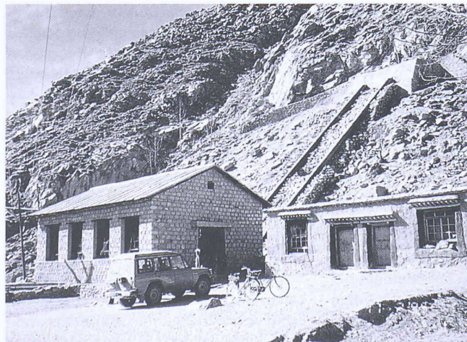
Kraftwerk Dön da: Zentrale (links), Turbogruppen (rechts)
