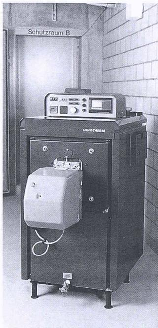
40°C und einen feuerungstechnischen Wirkungsgrad zwischen 98 und 99,5% auf. Dazu kommt noch der Anteil aus der Kondensationswärmerückgewinnung, so dass die Wirkungsgradverbesserung gegenüber alten Anlagen nachweisbar doppelt so hoch ist, als dies mit LRV-konformen konventionellen Heizkesseln möglich wäre - entsprechend grösser ist die Brennstoffersparnis und die Schadstoffverminderung.
