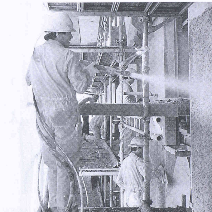
Bild 4. Auftragen der Spritzbetonverkleidung durch den Düsenführer. Im Hintergrund wird die Oberfläche nachgearbeitet
