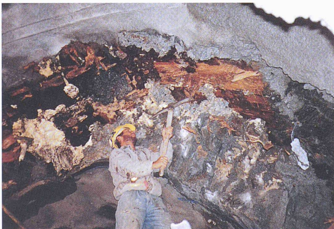
Bild 2. Altes und neues Tunnelgewölbe im Rufenen-Tunnel: Gut sichtbar sind die Hinterfüllungen
