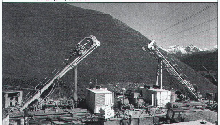
50 Baustelleneinrichtung für die Foralith-Tiefbohrungen.
