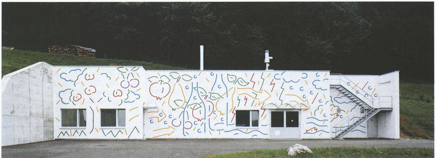
Gesamtansicht der Vorbehandlungsanlage
