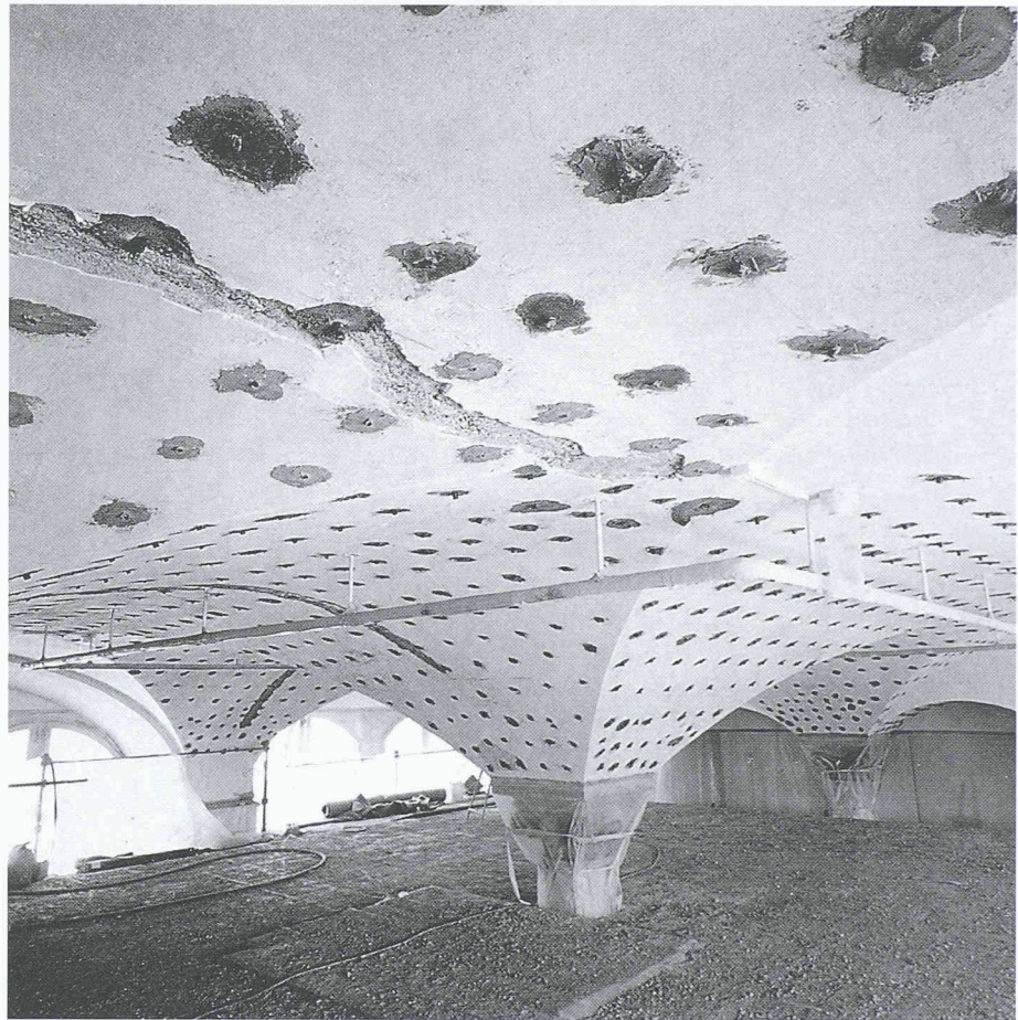
Gewölbedecke mit eingesetzten Bohrpäckern, Injektionsraster
