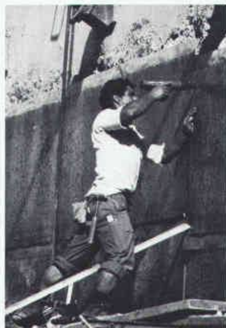
Problemlose Verlegung von Enkadrain CK auch auf unregelmässigem Untergrund
