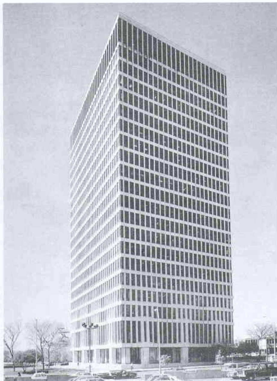
5 Marine Midland Bank Building, Rochester (NY), 1968 (Bild: David P. Billington; Robert Maillart, Birkhäuser Verlag AG, Basel)
