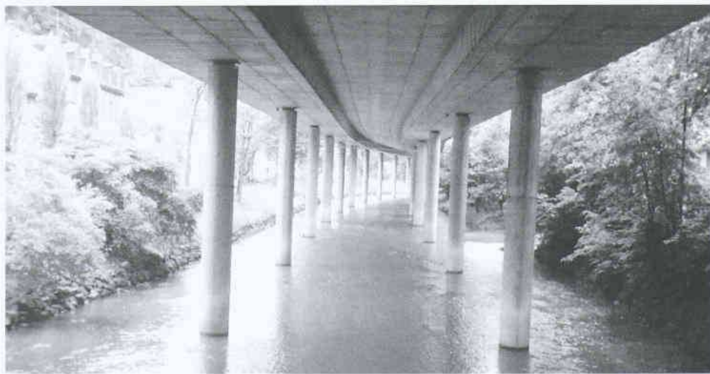
1 Nationalstrasse N3 in Zürich, Brückenuntersicht
