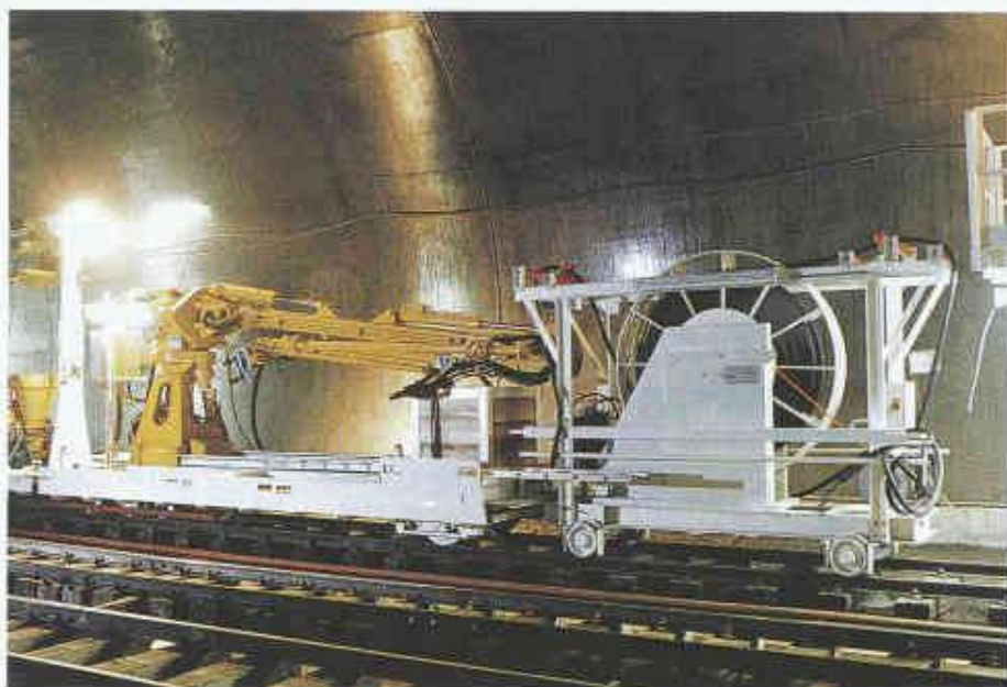
6 Blockzug II: Kabelspul- und Spritzwagen mit Düsenausleger
