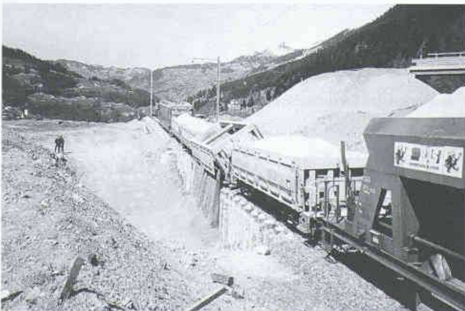
4 Kippwand Büel / 2 Fau- und 1 Fad-Wagen beim Entleeren (Foto: Bauleitung Nord)
