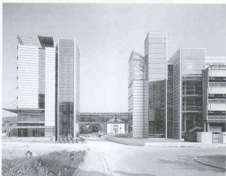
5 Empa St. Gallen, Verwaltungstrakt links, Labor- trakt rechts
