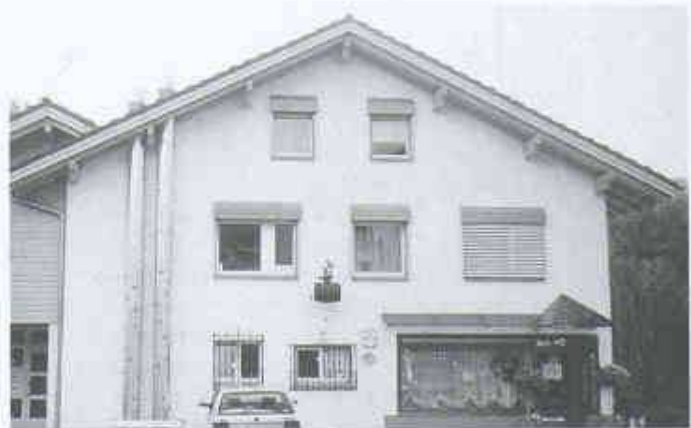
5 Wohnhaus und Restaurant Seehus in Hergiswil am Vierwaldstättersee: Die Stiftung für besondere Leistungen im Umweltschutz zeichnete den ökologisch ausgerichteten Um- und Anbau mit dem Preis 1996 aus. In der Mitte der Fassade: Rohre der Wärmerückgewinnungsanlage (Bild: T. Glatthard)
