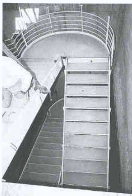
Montage der frei auskragenden, gut ausgesteiften Stahlterrasse
