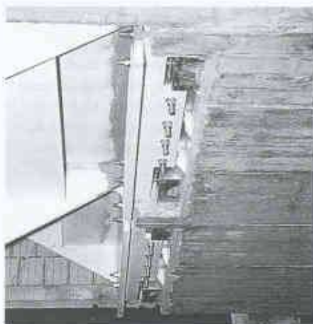
Aufnahme der vertikalen und horizontalen Kräfte durch zwei in den Achsen zueinander verdreht angeordnete Zug-Druck-Elemente. Oben: am Treppenfluss, unten: am Mittelpodest
