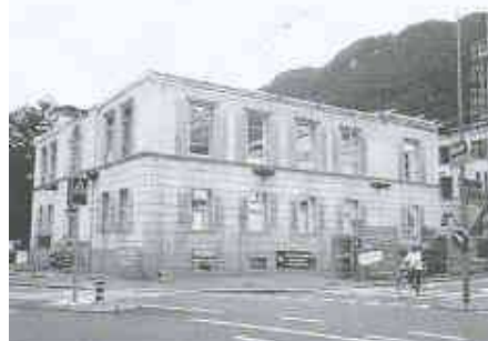
Das ausgekernte Gebäude im Sommer 1996
