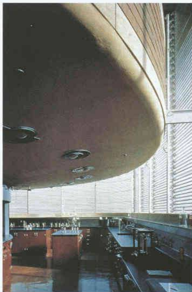
16 Glasröhren als «Energiepuffer»: Fassadenhaut der Johnson's-Fabrik in Racine, Wisconsin (Architekt: Frank Lloyd Wright, 1936-39 und 1944-50); oben
