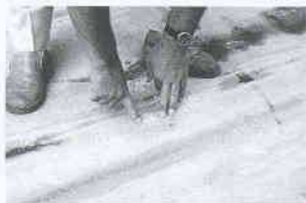
11 Dübel bei Belastung sichtbar
