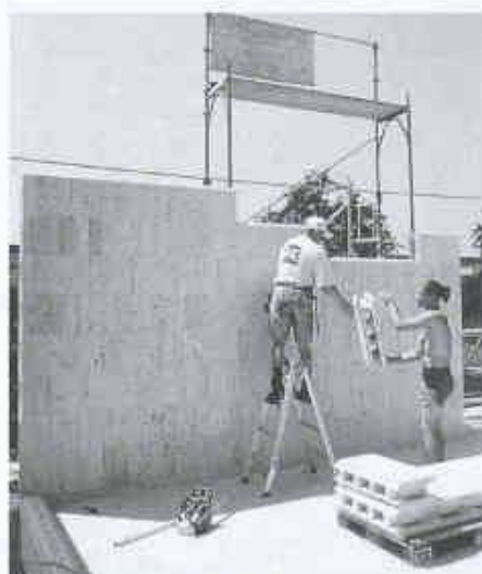
Aufbau der Steko-Wände (alle Bilder: S. Schupisser, Arbon)
