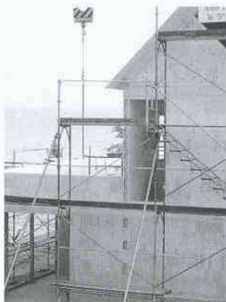
Pilotobjekt im Rohbau, erstellt in drei Tagen
