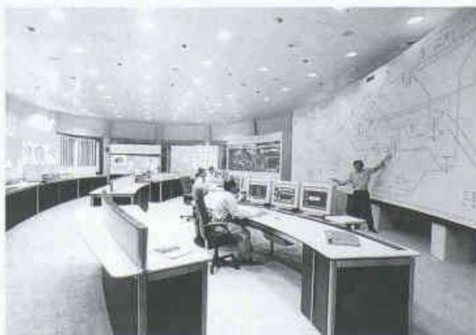
Herzstück des Neubaus ist der Kommandoraum der Energie- und Netzleitstelle. Hier wird rund um die Uhr das Stromversorgungsgebiet der NOK überwacht (Bilder: H. Krebs, Ottikon)
