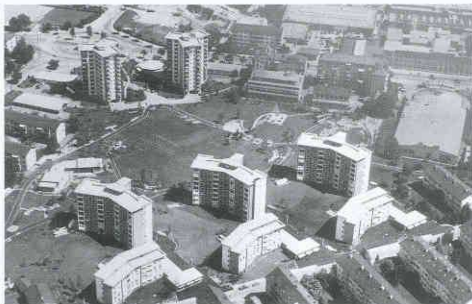
Siedlung Heiligfeld in Zürich-Albisrieden (1950–54) von Stadtbaumeister Albert Heinrich Steiner
