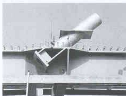
4 Spannkabel: Verankerungsdetail
