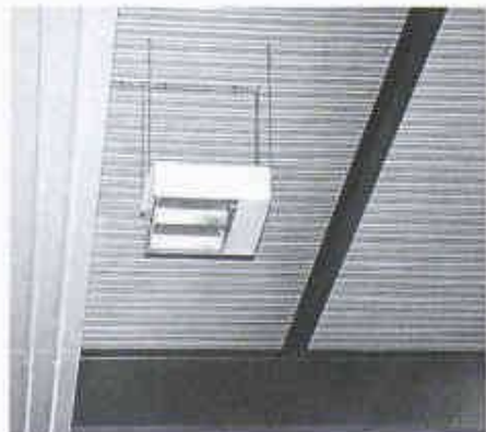
5 Perforiertes Profilblechdach (Objekt: Neubau Servicehalle, Meyer Waggon AG, Rheinfelden)
