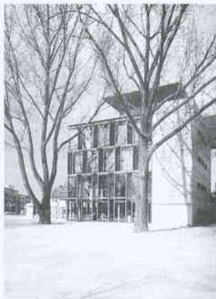
(Bild: H. Helfenstein, Zürich)
