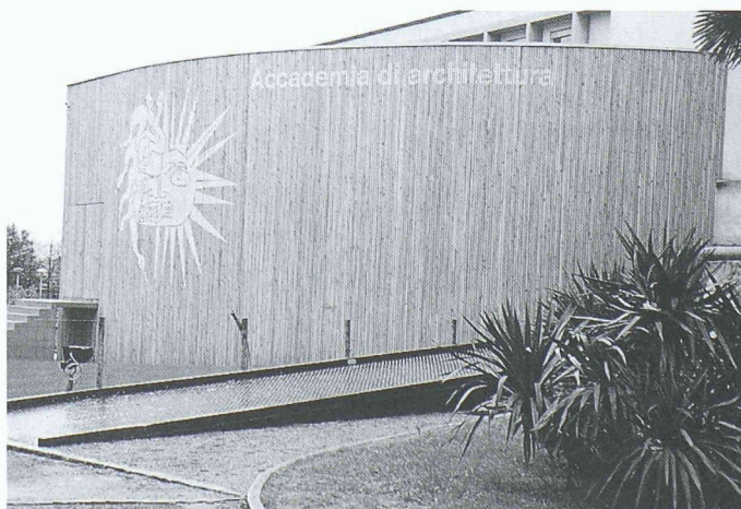
Aula der Accademia, ein zweckmässiger Holzbau mit 500 Plätzen. Der Aufbau erfolgte mit vorfabrizierten Elementen aus Douglasfichte
