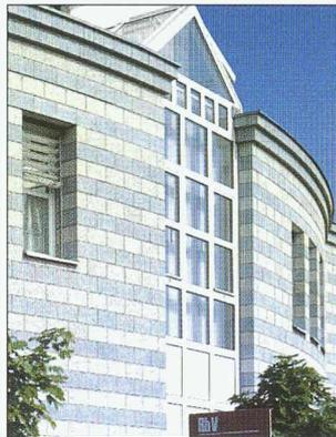
Damit bietet OCTAVANT die Möglichkeit, unzählige Ideen der Aussen- und Innenwandgestaltung mit wenigen Elementen zu verwirklichen: Alternierende Streifen, siensische Bänderungen, Rollschichten, Übereck-Konfigurationen, Diagonalverläufe, das Spiel mit kontrastierenden
