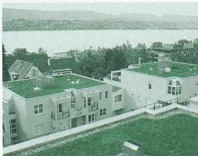
Nutzbar gemachtes Flachdach: Sarnavert Extensivbegrünung auf Sarnafil T.
