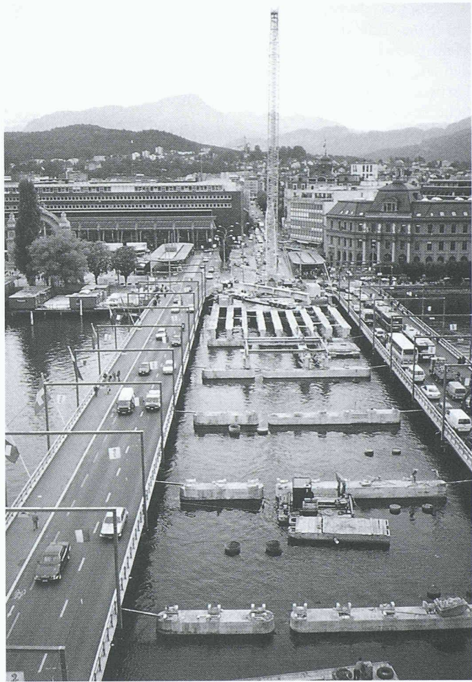
3 Rückbau der alten Brücke. Der Verkehr fliesst auf den beiden Hilfsbrücken
