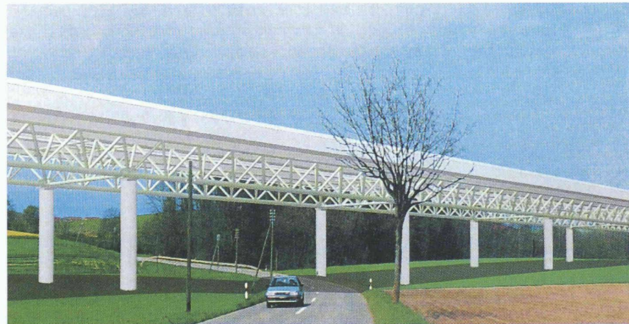
8 Viadukt von Lully (CH) – Rohrfachwerk
