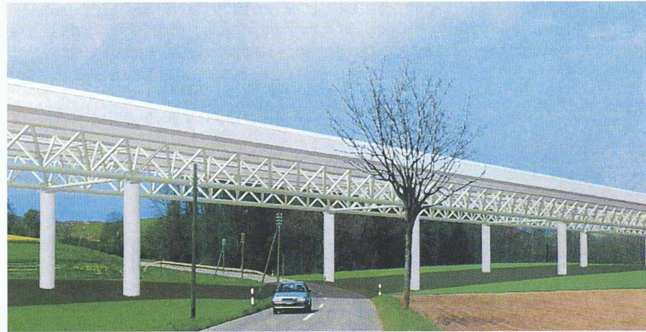
8 Viadukt von Lully (CH) – Rohrfachwerk
