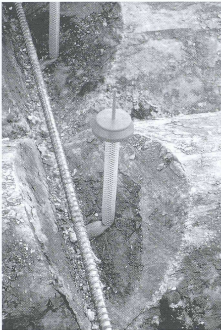
2 Detail der Kerbe und vorgespannter Dübel
