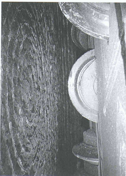
Blick durch Bohrkopf in den Arbeitsraum zwischen Schneidräder und Ortsbrust
