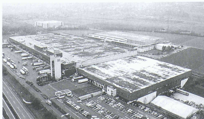
Migros-Verteilzentrum Neuendorf nach der ersten Sanierungsetappe von 8000 m 2
