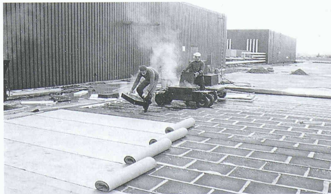
Verlegen der Foamglas-Dämmplatten T4 auf den Trapezblechuntergrund und anschliessende Abdeckung mit Dichtungsbahnen
