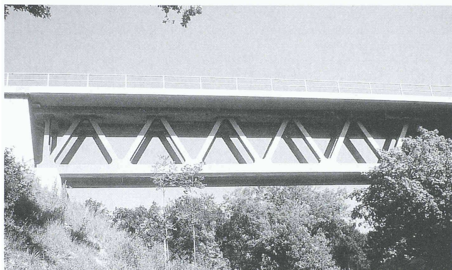
Eisenbahn-Fachverbundbrücke bei Wasserburg (Südbayern)
