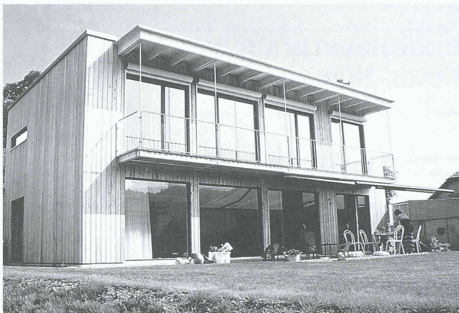
Niedrigenergie-Einfamilienhaus im Minergiestandard in Tafers FR (1997), Energiekennzahl 30 \text{ kWh/m}^2\text{a} . Architekt: Heribert Binz, Schmitten (Bild: Holzforum)
