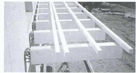
Wärmegeprägter Kragbalken aus Holz. Sichtbar sind die Einhängezughaken und die bereits vorbereitete Querausparung der Balkonplatte (Bild: Schöck-Bauteile AG)
