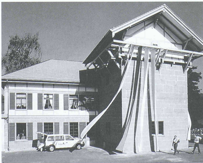
Appreturgebäude und angebauter Tröckneturm von 1861 nach der sorgfältigen Restaurierung (Bild: Jürg Stauffer)
